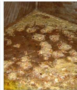
Dépôts de vernis sur le réservoir plancher du réservoir
