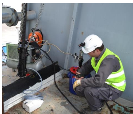
Opérations de graissage de câbles
