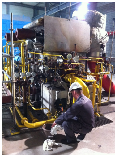
Inspection et installation sur site
