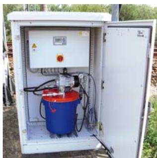
Coffret de distribution de graisse autonome
